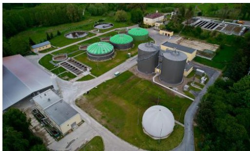
Oczyszczalnia ścieków w Sierpcu (Fot. EMPEGEK)
